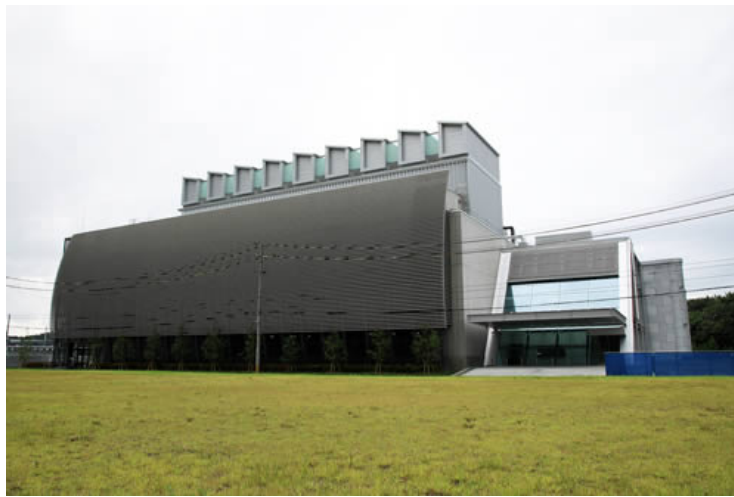
白河データセンター1号棟（右側は管理棟）
