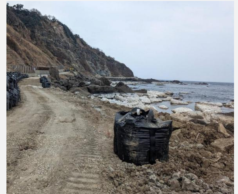
B集落に続く道路の“仮復旧後”の状況 (阿部撮影)
