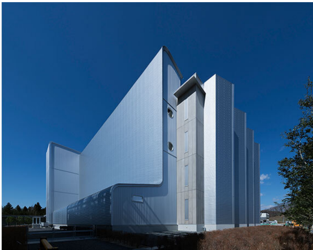
環境配慮型の次世代データセンターを建設
